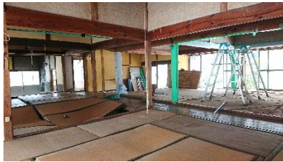
解体工事が進んでいます。
