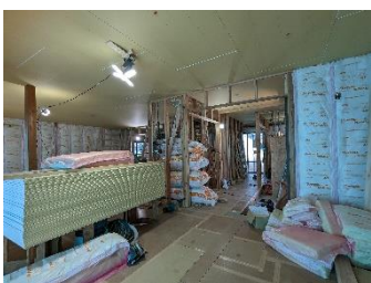
LDK部分 断熱の施工が終わりました
