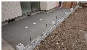
コンクリート打設 犬走り部分
