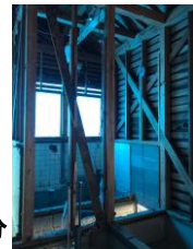
解体中 浴室部分
