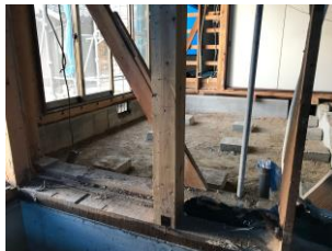
解体中の様子
