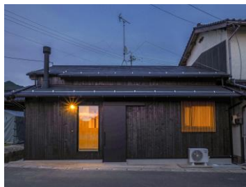
施工後 外観正面
