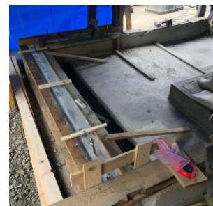
施工中 お風呂場の基礎補強
