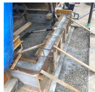
施工中 基礎補強
