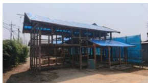
手前にあった和室は解体されました
