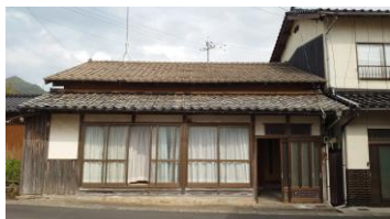
施工前 外観正面
