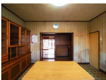
施工前 キッチン
