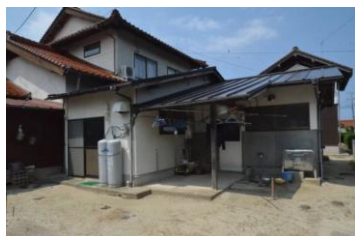
施工前 外観の様子
