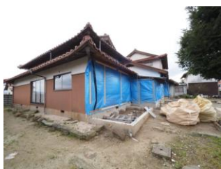
解体中 残っている基礎はこれから壊します
