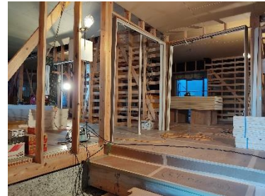
施工中の玄関まわり
