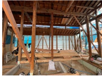
スケルトン状態に解体しています
