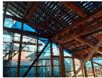
スケルトン状態に解体しています
