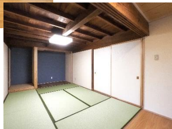
以前の天井を活かした客間
